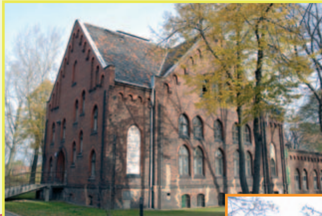
Haus Zionsstille. Es wurde 1905 eingeweiht und diente als Gästehaus und Schwesternwohnheim
