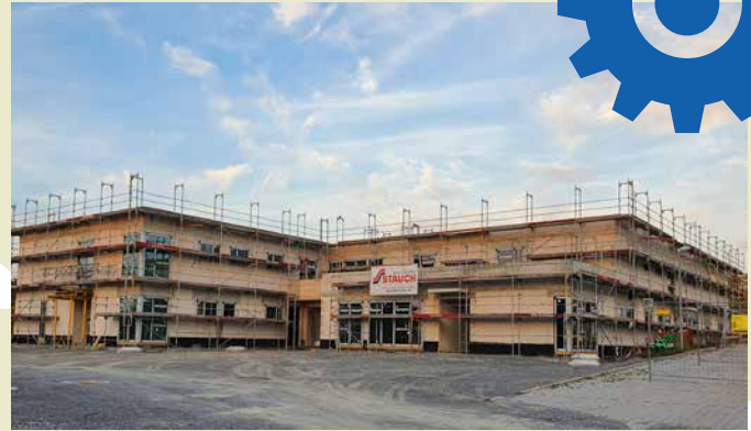
Die Kita-Baustelle Mitte Oktober 2022
