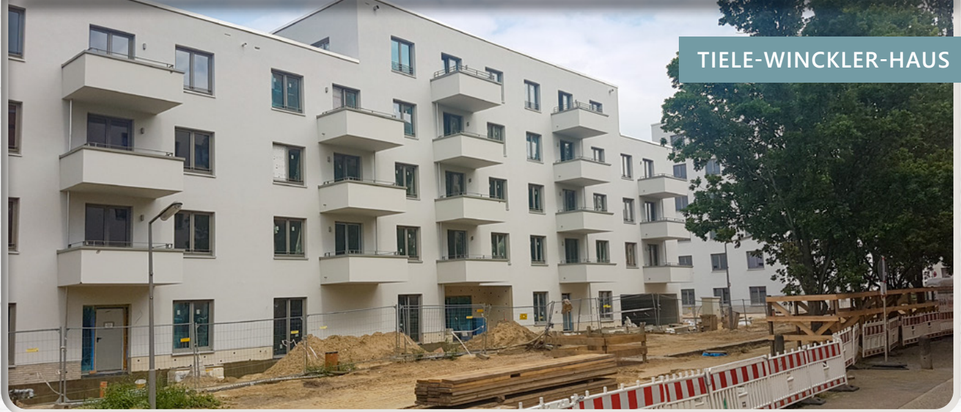
Baufortschritt im Juli 2021
