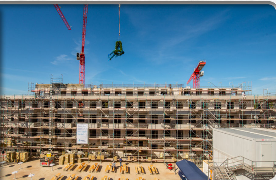
Richtfest der Degewo Wohnungsbaugesellschaft (© Foto: Konzept und Bild / Cathrin Bach)
