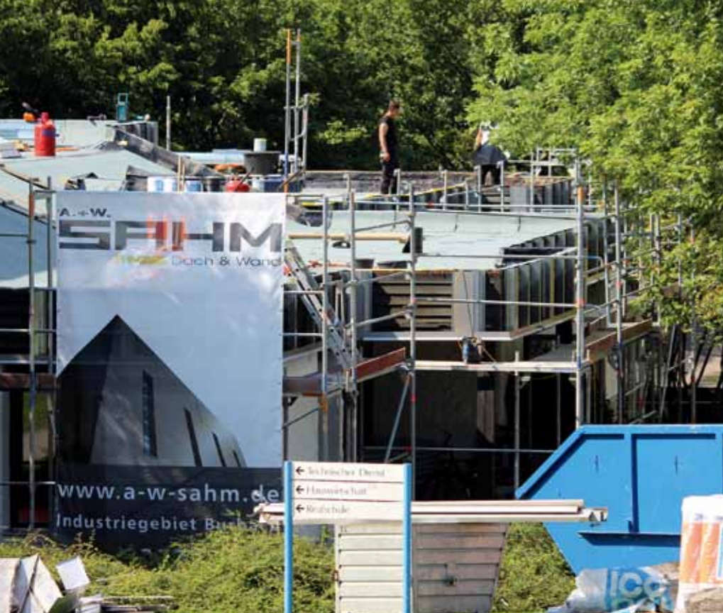
Die Sommerferien werden genutzt, um weitere marode Dächer auf dem Cappelrain-Gelände zu sanieren.
