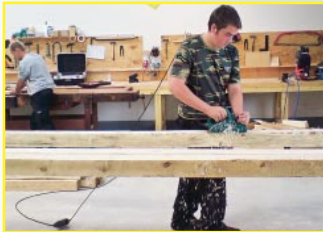
Schreinerarbeiten sind ein wesentliches Element im Kulissenbau.
