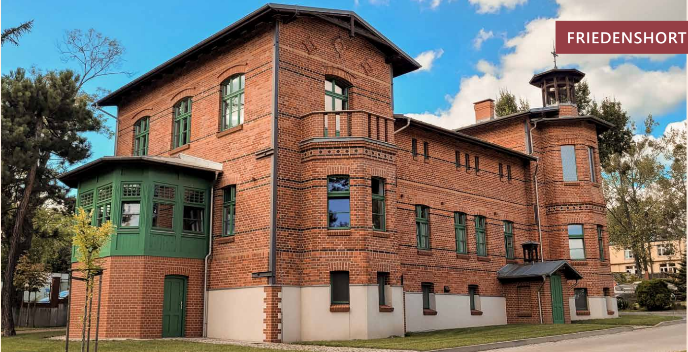
Haus Friedenshort erstrahlt nach Sanierung in neuem Glanz
